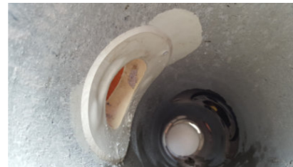
Verpresster Stutzen Epoxidharz
