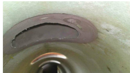
Verpresster Stutzen Mörtel
