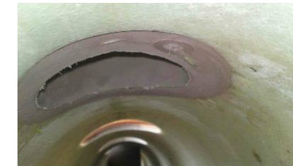
Verpresster Stutzen Mörtel
